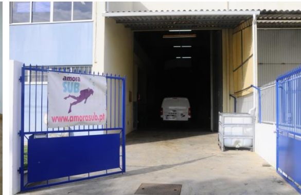
Entrada do Armazém
